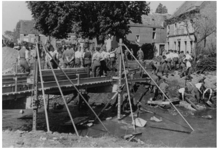
Deutsche Pioniere bauen eine Notbrücke in Itgem
